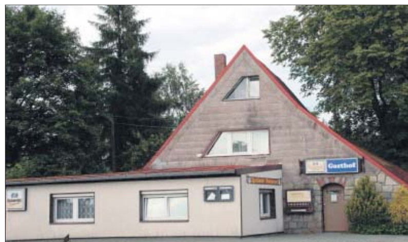
Das Streitobjekt, der ehemalige Gasthof „Zum Egerländer“.
